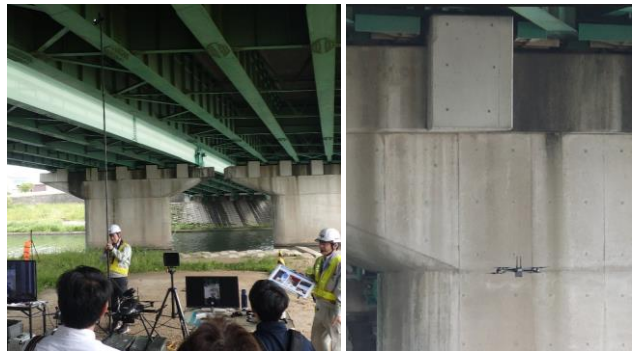
非GNSS環境対応型ドローンやボールカメラを用いた近接目視点検支援技術
