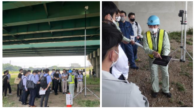
橋梁等構造物の点検ロボットカメラ
