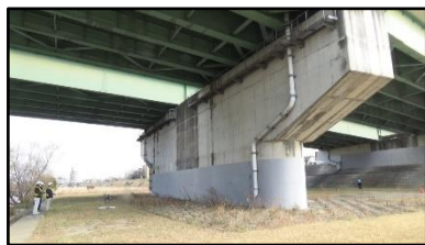
名古屋市 某橋梁(中部地方整備局) 現場ニーズと技術シーズのマッチング
