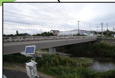
豊橋市内 某橋梁
