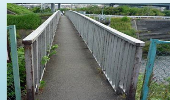
橋梁点検車が入れない
