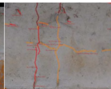
ひびわれ表示詳細 (ひびわれ幅により色分け)
