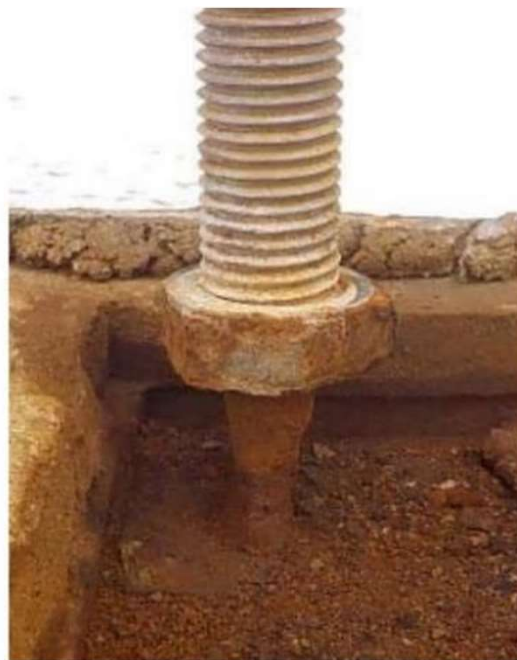
ボルト基部の腐食 ＜塚田啓二氏 確認＞
