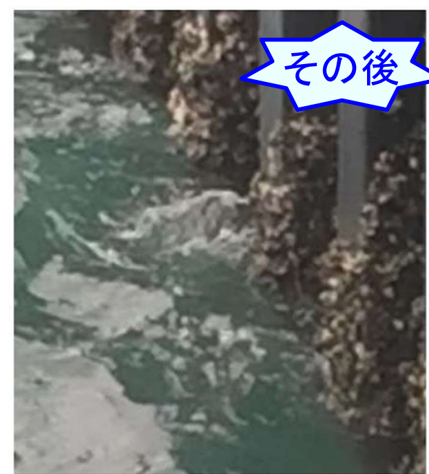
水中付着物下の腐食
